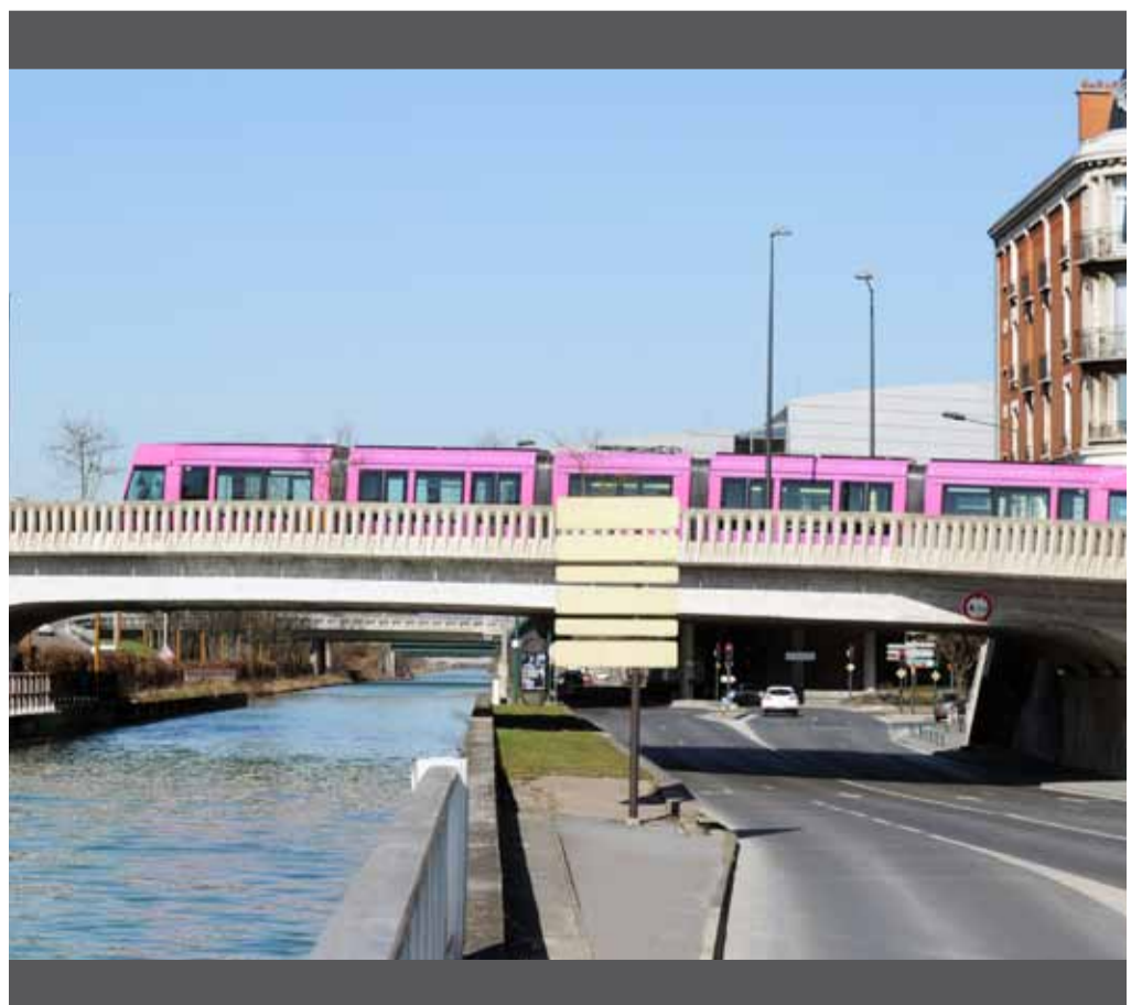
Pont de Vesle
