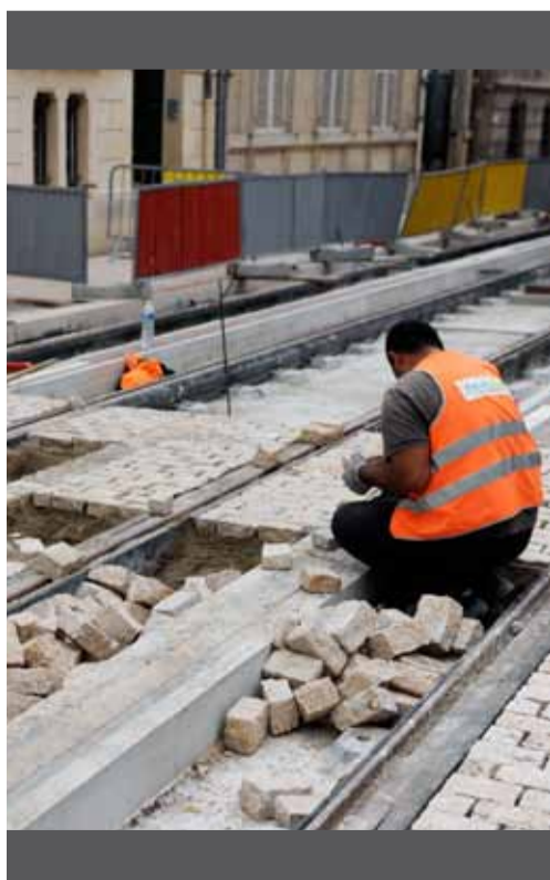
Travail de grande finition avec la pose de pavés notamment sur la plate-forme.
