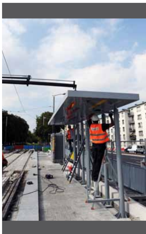
Installation du mobilier urbain et des stations de tramway.
