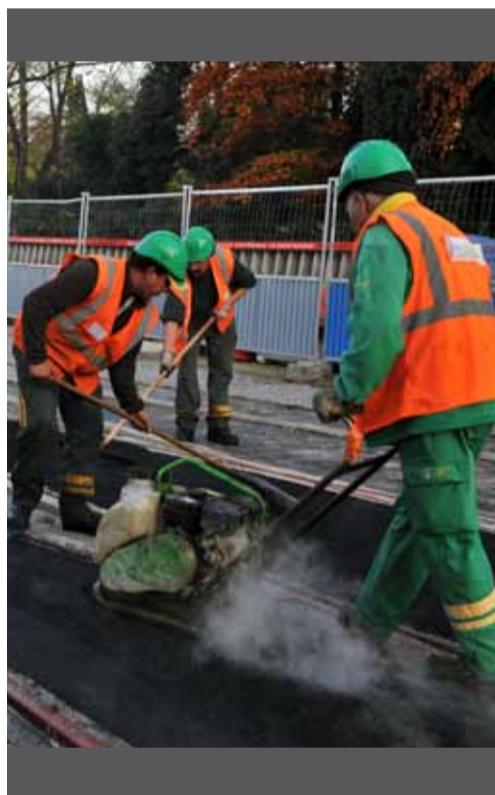
Réalisation de l'enrobé sur la plate-forme entre la voie ferrée.
