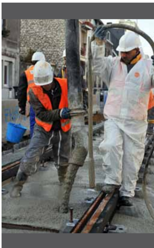
Coulage du béton de calage de la voie ferrée sur la plate-forme.
