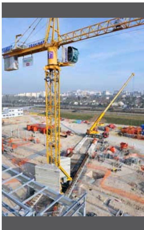
Construction du Centre d'Exploitation et de Maintenance à Bezannes, de août 2009 à mai 2010.
