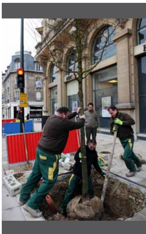
Plantation des arbres, une opération qui a débuté à l'automne dernier.
