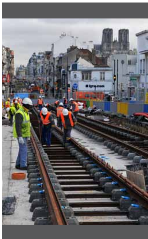
Différents types de pose de voie ferrée ont été utilisés dont la pose de voie prémontée.
