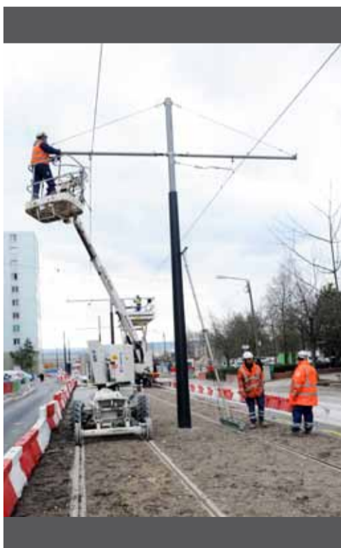
Tirage de la Ligne Aérienne de Contact (LAC), un travail de haute précision.
